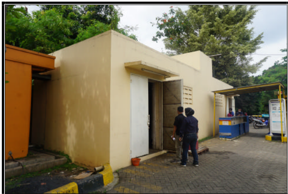
RUMAH GENSET GENERATOR HOUSE
