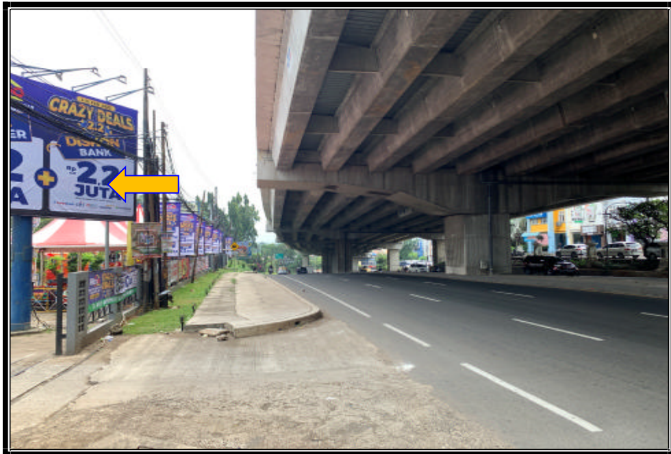
JALAN DI DEPAN LOKASI (JL. ALTERNATIF CIBUBUR) DARI ARAH BARAT/ ROAD IN FRONT OF LOCATION (JL. ALTERNATIF CIBUBUR) TAKEN FROM WEST DIRECTION
